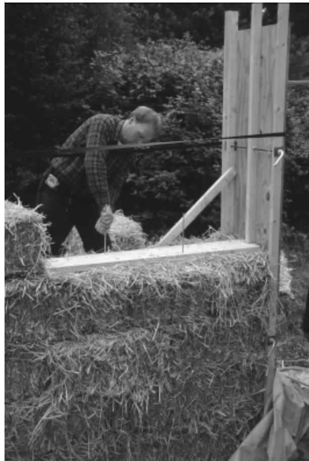
Verbinden der Ballen mit Bambusstäben
