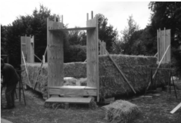
Errichtung der Strohballewände
